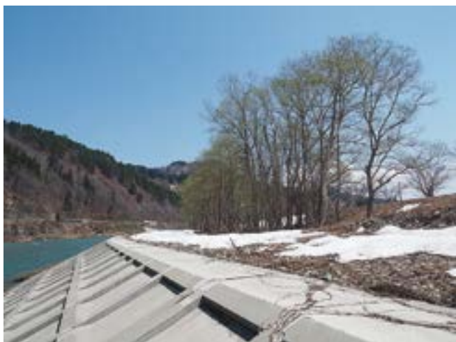
大倉左岸に新たに築かれた護岸堤防 2020年4月20日撮影
