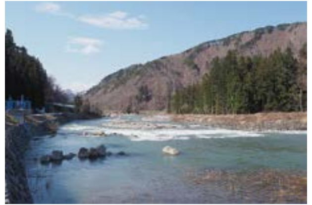
護岸工事がなされた温谷沢出合下流 2022年4月20日撮影
